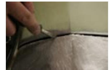
Sven Billred har tillverkat två verktyg som han använder för att ritsa korrekt springa mellan plåt-detaljerna.
